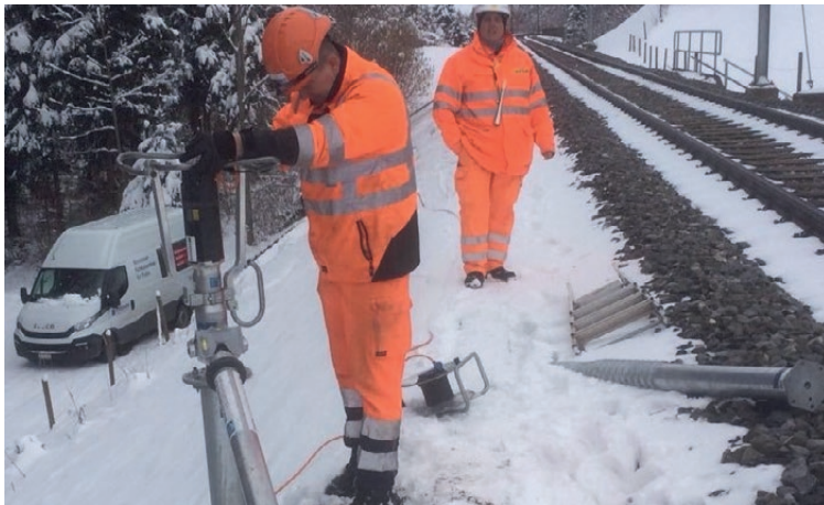
Installation directe sur la ligne ferroviaire
