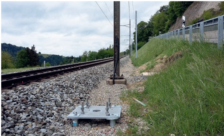
Fondation du mât terminée
