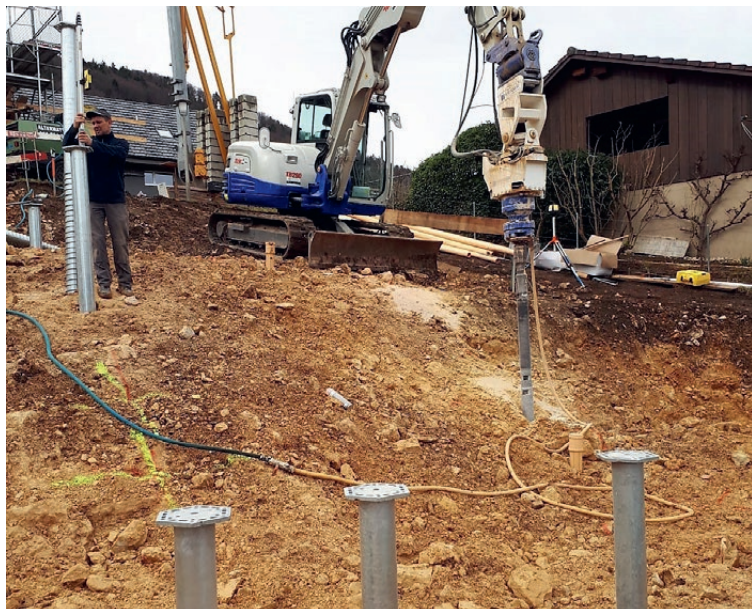
Mise en place des vis de fondation
