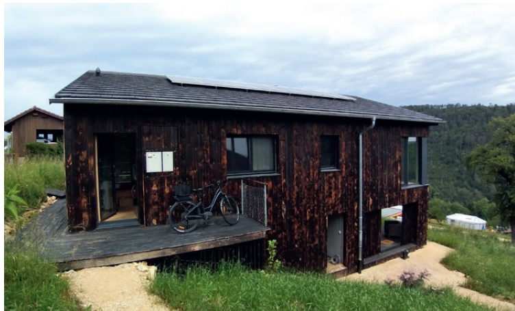
Mise en place de la terrasse
