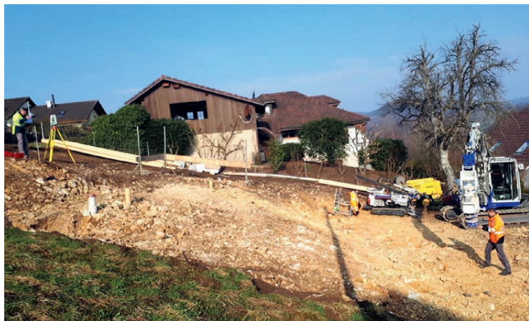
Construction dans terrain en pente
