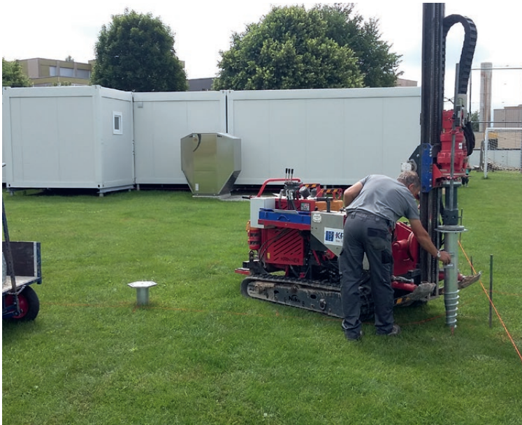
Mise en place des vis de fondation avec la KRD 55
