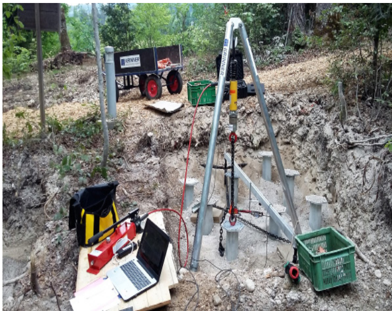
Tests préliminaires d'arrachement
