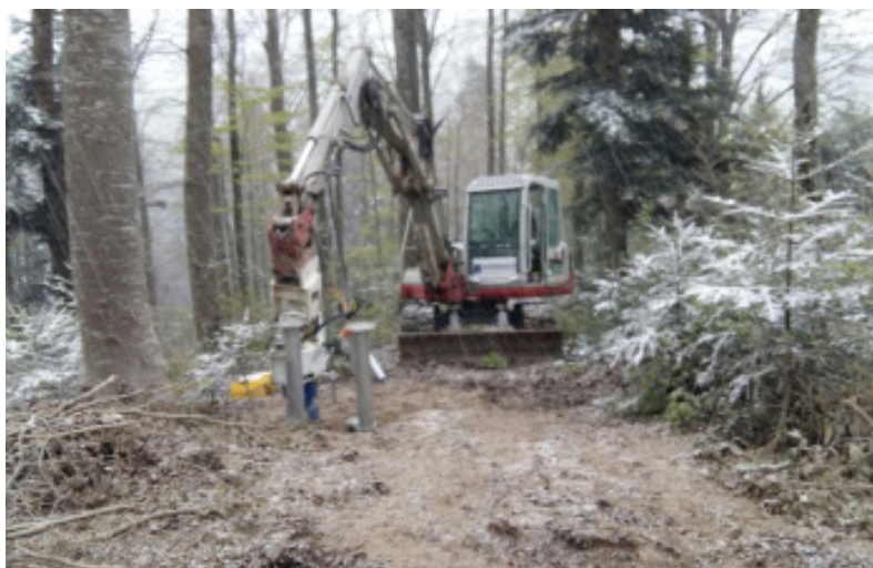
Vissage des fondations à l'aide d'une excavatrice avec tête KRB 250
