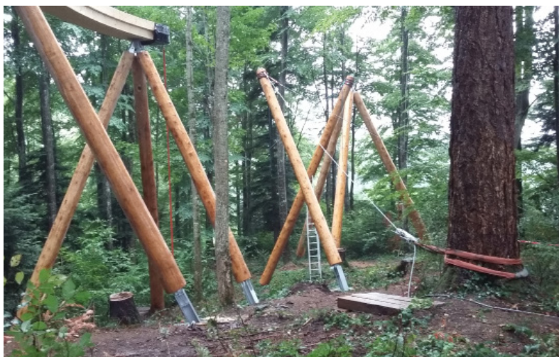
Construction en bois finie
