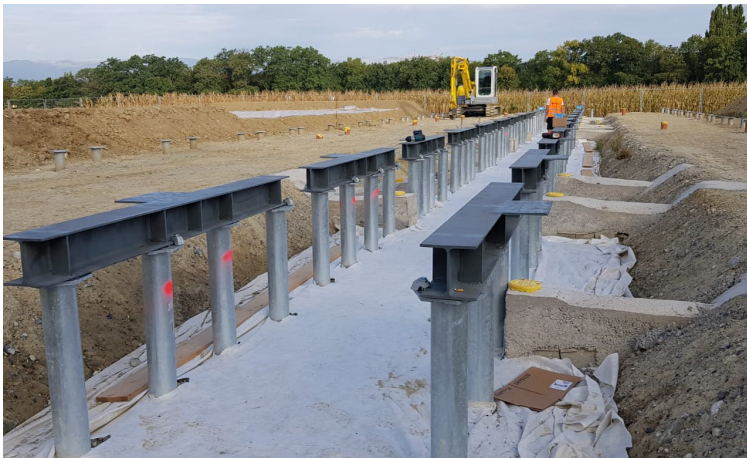
Vue d'un bâtiment, vis posées
