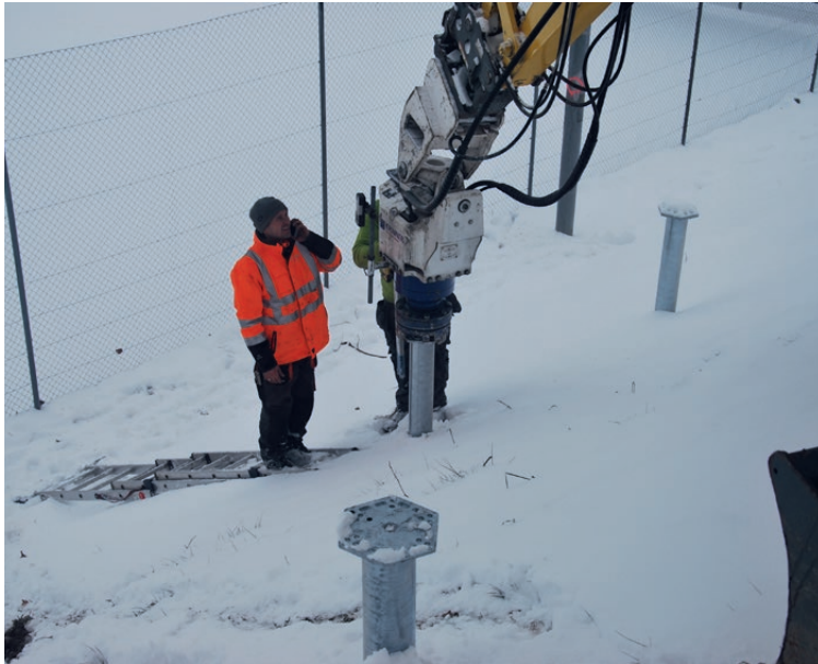
Pose des fondations de 3,6m au moyen d'une pelle hydraulique
