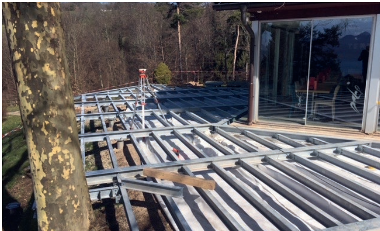
Pose de la structure métallique sur les vis de fondation
