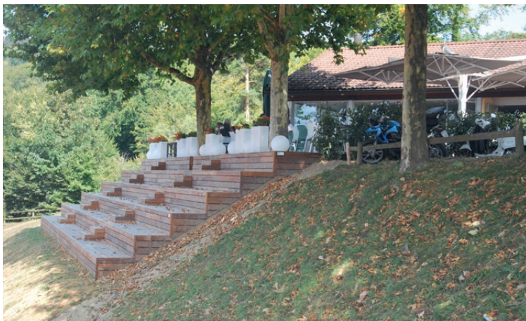
Couverture en bois sur l'entier de la terrasse et des gradins
