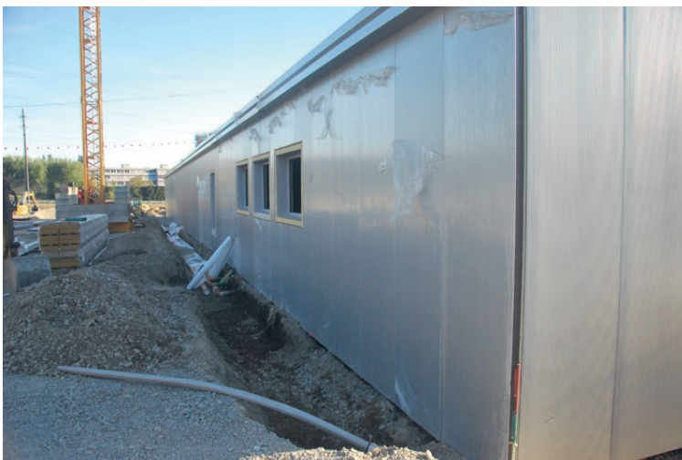
Finition du bâtiment, pose des parois externes
