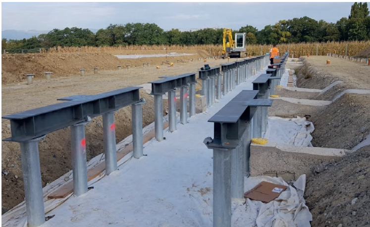
Vue d'un bâtiment, vis posées
