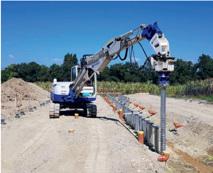
Mise en place des vis de fondation au moyen de la KRB 250
