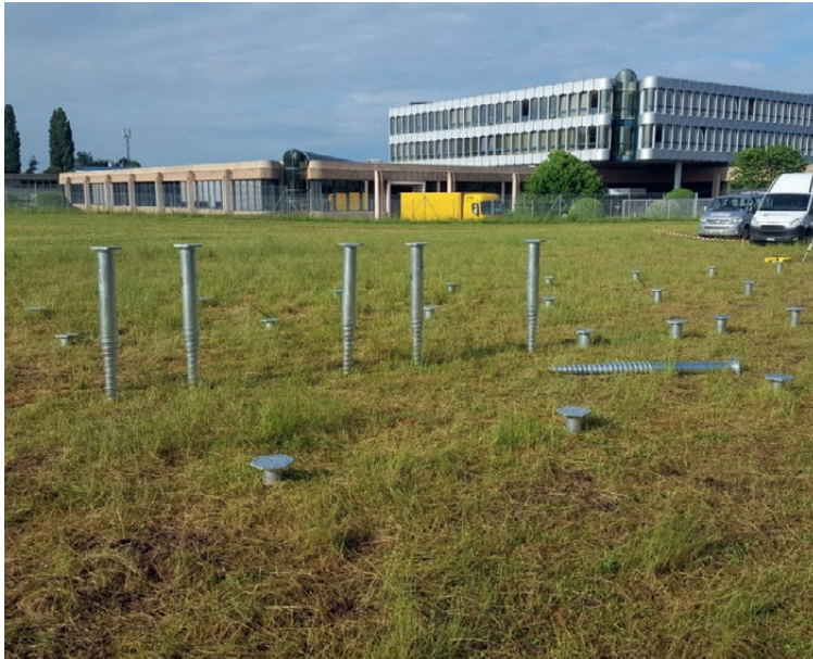
Mise en place des vis de fondation
