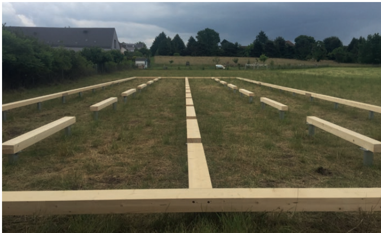
Mise en place de la structure bois
