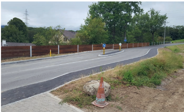
Mur anti-bruit en cours de finition
