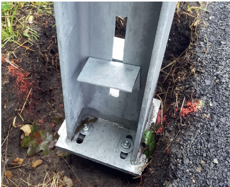
Le profil est vissé sur la platine de la vis
