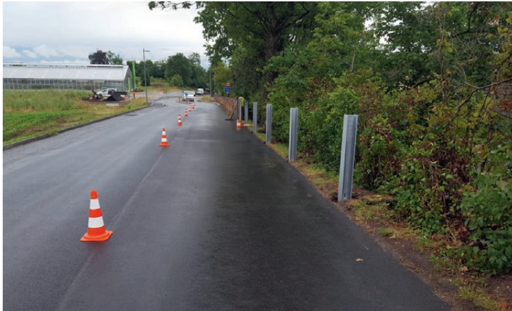
Fixation des profils métalliques
