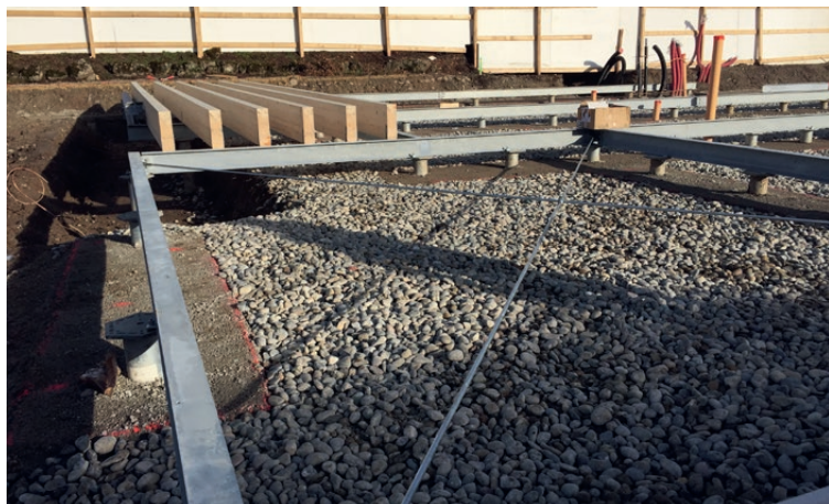
Création d'une plate-forme renforcée pour le bâtiment d'extension
