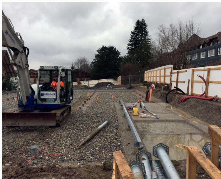
Fondations vissées et poutres d'acier pour la réalisation temporaire
