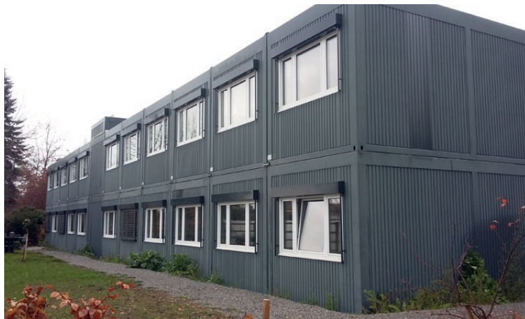
Complexe de conteneurs en logement temporaire
