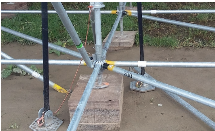
Detail der Zugabspannung des Tribünenendaches
