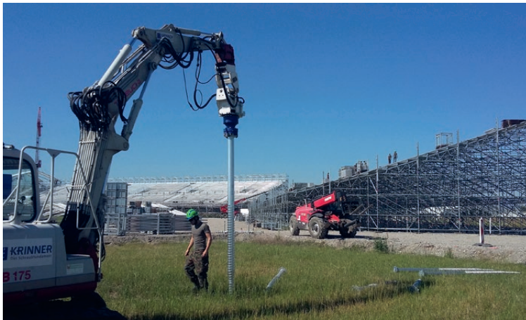
Einbau der Schraubfundamente mit Baggeranbauerät KR B 250
