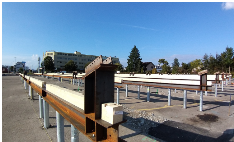
Pose des fondations vissées dans le revêtement bitumineux fermé
