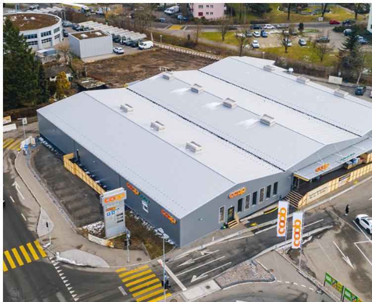
Vente provisoire sur fondations vissées à Bachenbülach
