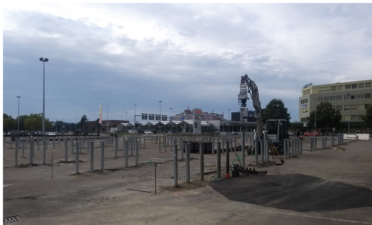
Les fondations vissées et les poutres ont été fournies et installées par Krinner.
