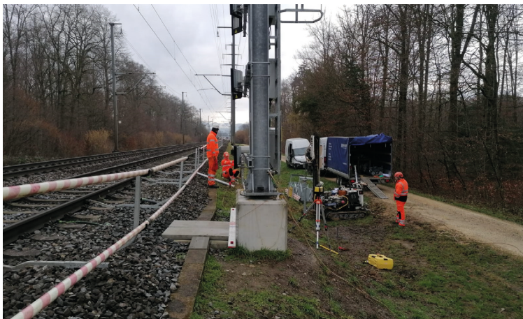
La machine de vissage électrique permet de monter des fondations vissées même sur des terrains en pente
