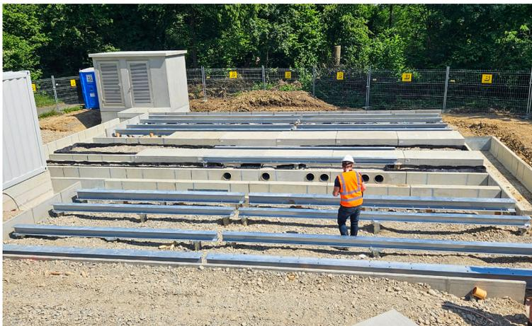
Les poutres en acier galvanisé sont fixées sur les fondations vissées
