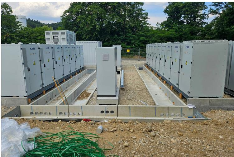
Le stockage par batterie repose sur des fondations vissées Krinner
