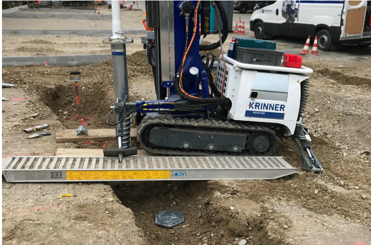
Installation des fondations vissées avec le véhicule à chenilles KRD 30
