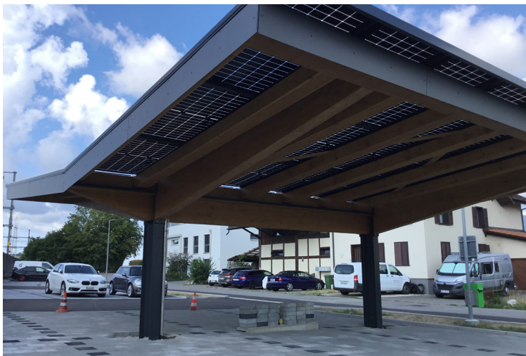
Carport solaire sur fondations vissées Krinner
