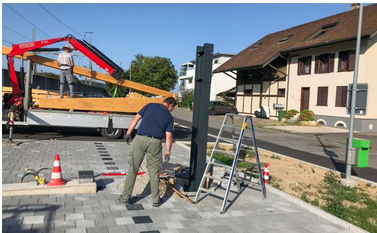
Des poutres en acier et des vis forment une fondation stable sous les dalles de pierre
