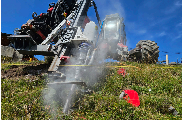
Le pré-perçage permet une installation dans un sol rocheux
