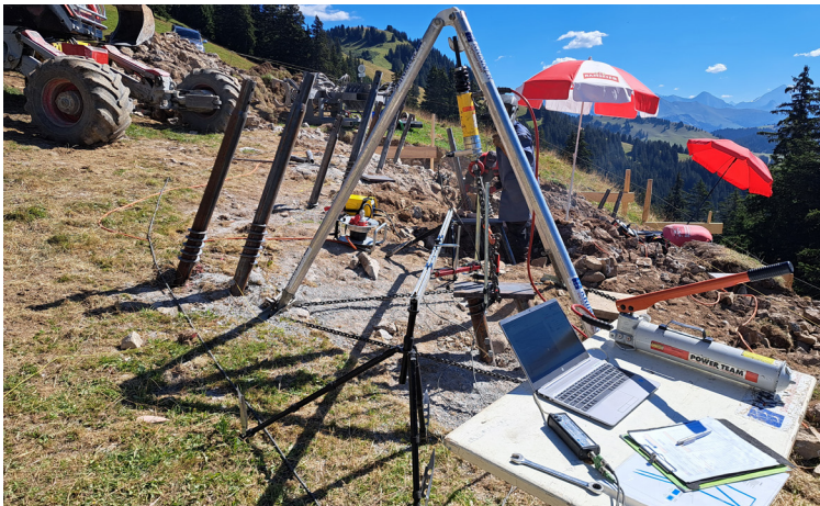
Tests de charge (traction) pour caractériser la reprise de charge
