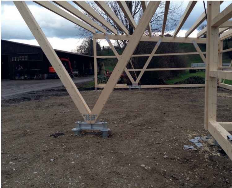
Montage der Holzkonstruktion auf die punktgenauen Fundamente
