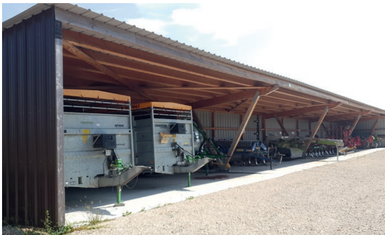
Die Holzkonstruktion dient als Unterstand für Maschinen und Fahrzeuge
