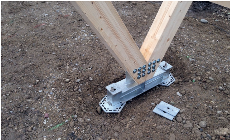
Stahltraverse mit 2 Schraubfundamenten zur Aufnahme der Holzkonstruktion
