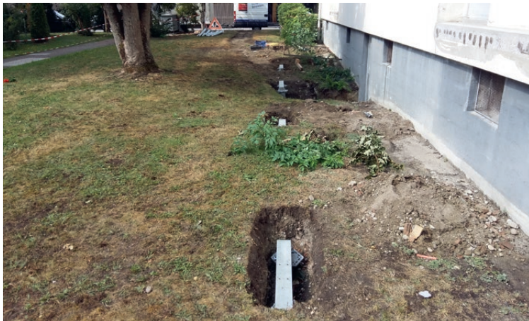
Traversen mit integriertem Lochbild für die genaue, schnelle Montage der Balkontürme
