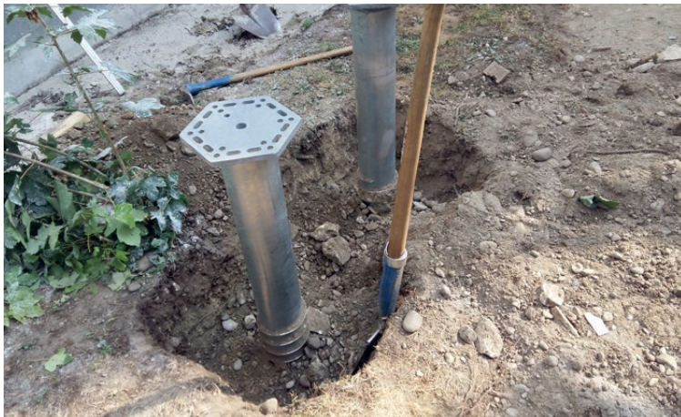
Erstellung Handaushub bei teilmontierten Schraubfundamenten
