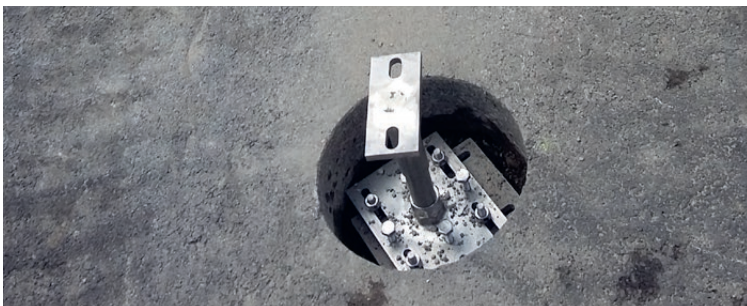
Millimeter genau montierte Adapter für Montage des Unterstandes
