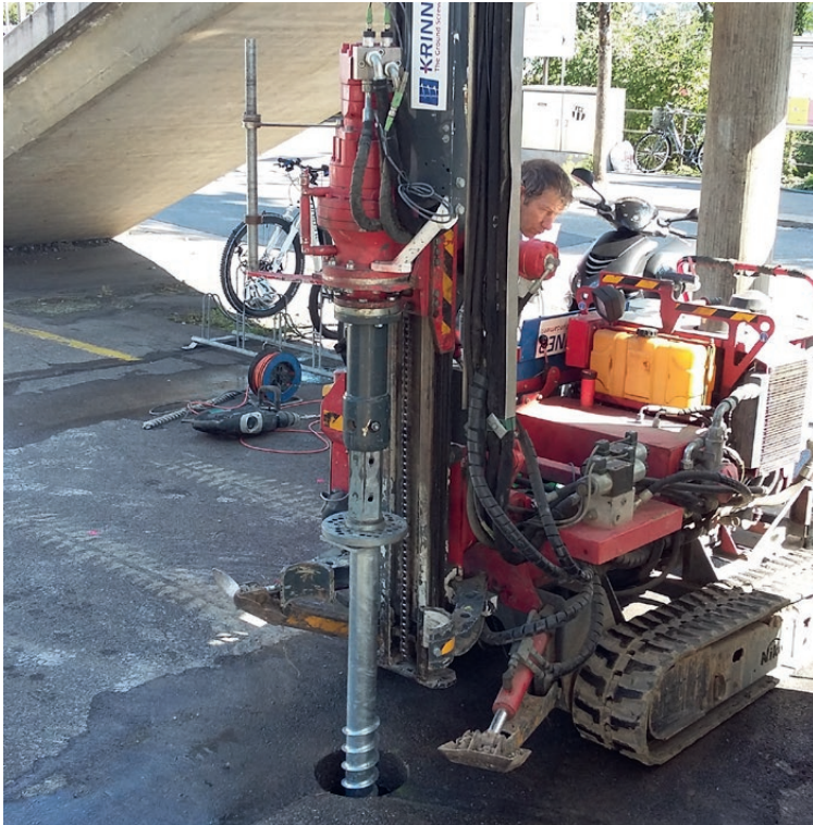
Einbau der Schraubfundamente nach Kernbohrung im Asphalt
