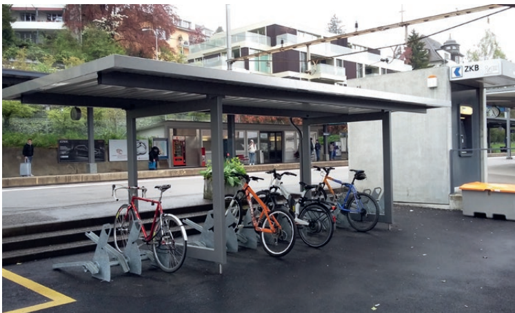
Unterstand mit sichtbarem Chromstahladapter als Verbindung zum Fundament
