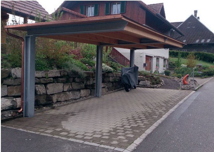
Das auskragende Dach erlaubt das längsseitige Parkieren.
