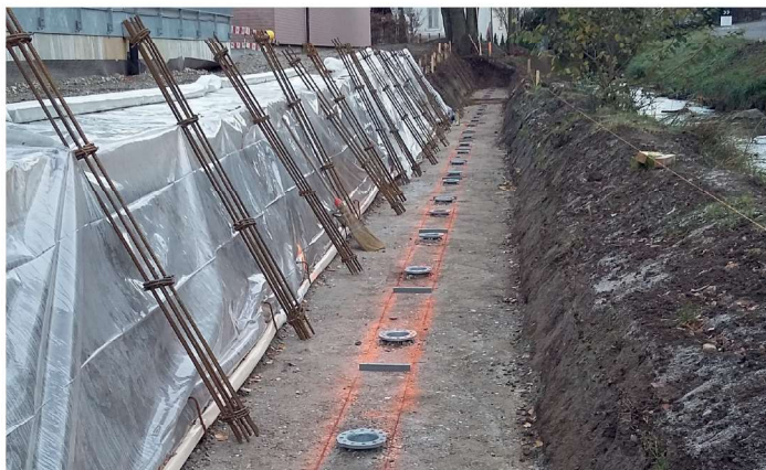
eingebaute Schraubfundamente vor dem Einstellen der Armierung
