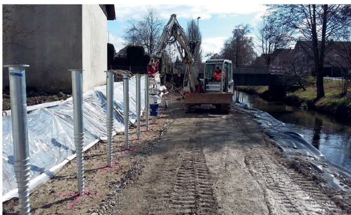
Einbau der Schraubfundamente mit Baggeranbaugerät KR B 250
