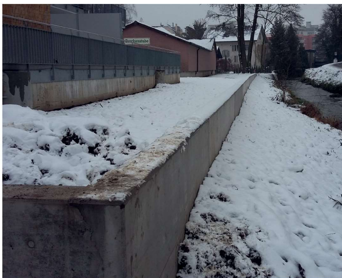
Hochwasserschutzwand aus Beton mit integrierten Schraubfundamenten
