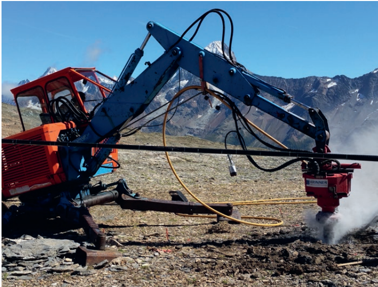
Vorbohren im Fels mit KR B 60 an vorhandenem, historischen Schreitbagger
