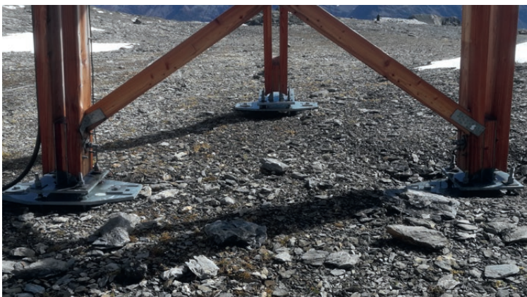
Stahladpater mit zwei Schraubfundamenten zur Aufnahme der Holzstützen
