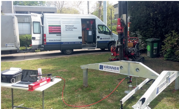
Baugrundabklärung mittels Belastungsversuchen (Druck)
