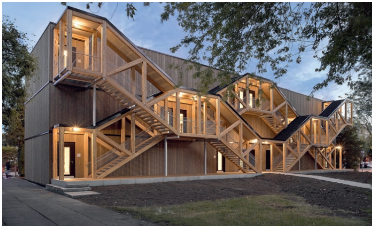
Fertig erstelltes Schulhaus in Modulbau Holz
