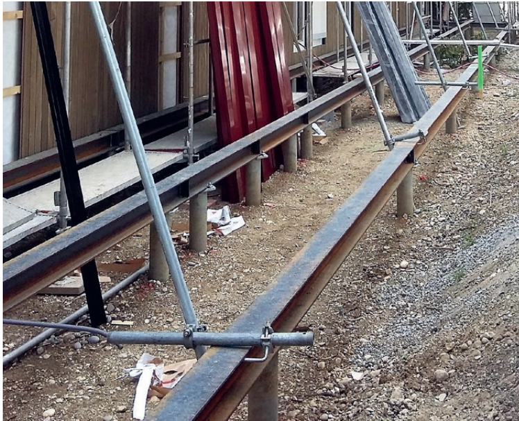
Stahlträger auf Schraubfundamenten
