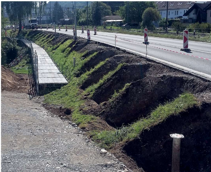
Vorbereitungsarbeiten: punktueller Aushub für Einba der Schraubfundament am Hang
