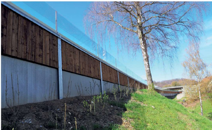
Fertig erstellt Lärmschutzwand an der Steilböschung
