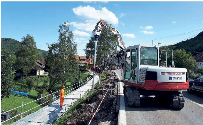
Einbau eines Schraubfundamentes der Länge 6.5 Meter mit Baggeranbaugerät KRB 250
