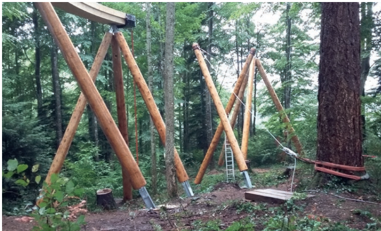
Aufrichten der Holzkonstruktion mittels Stahladapters auf Schraubfundamenten.
