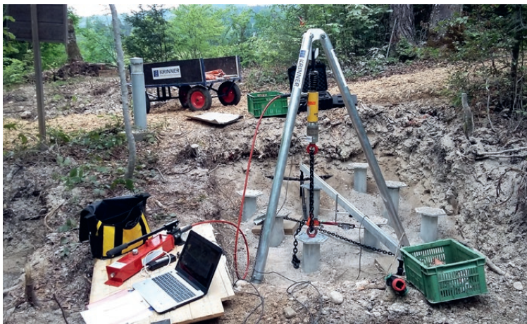
Abnahmeprüfung (Zugprüfung) zur Fundamentfreigabe
