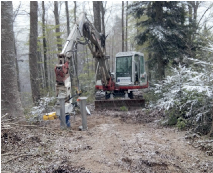
Eindrehen der Schraubfundamente mit Baggeranbaugerät
