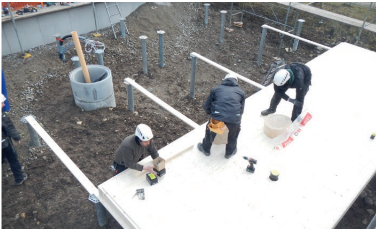
Montage der Bodenelemente auf Schraubfundamente
