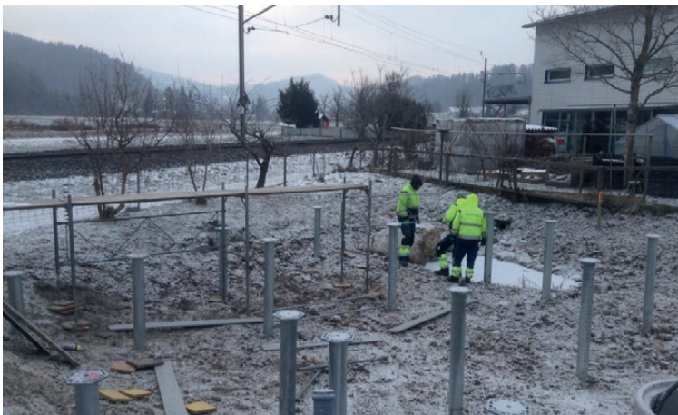
Einbau der Schraubfundamente bei Frost
