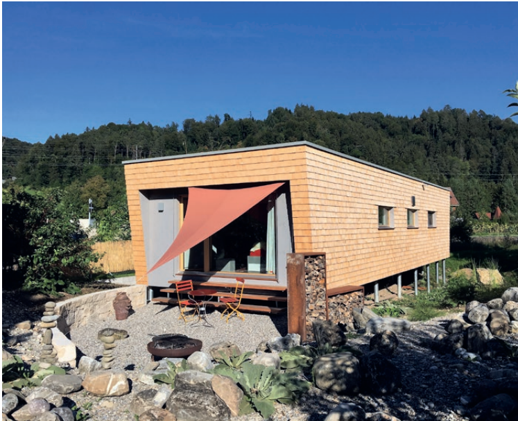
Fertiges Haus mit gut sichtbarem Hangausgleich
