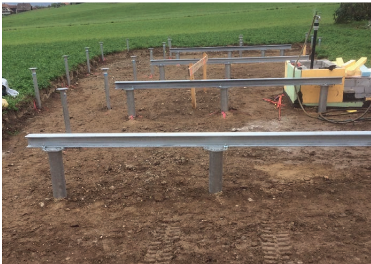
Stahlträger im Hausbereich, Terrassenfundamente als Direktauflager für Holzbalken
