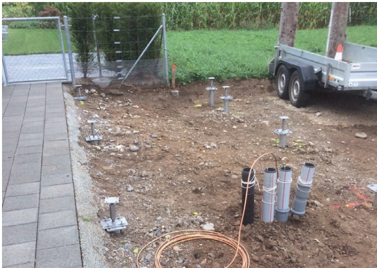
Beim Schopf wurden für die Holzstützen KSF F-R und Pfostenträger eingesetzt
