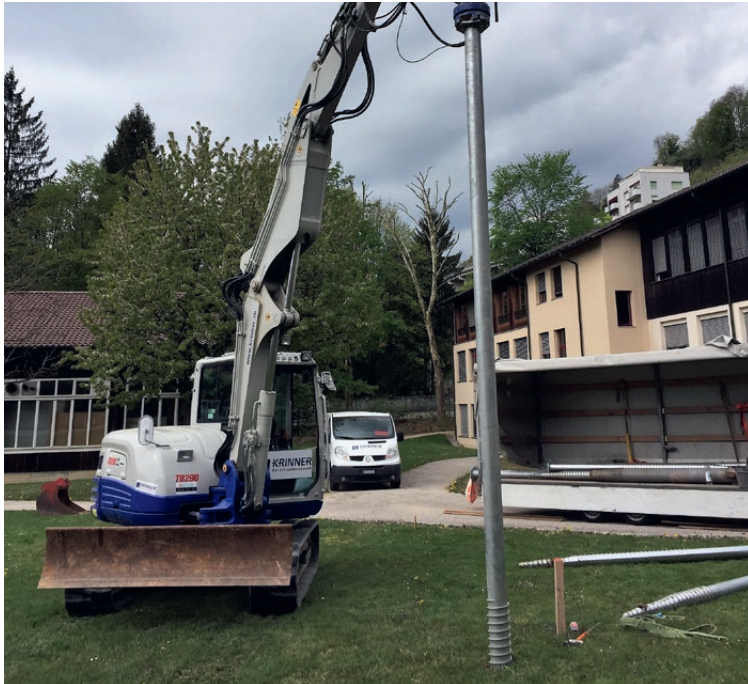
Einbau der 6.5 Meter langen Schraubfundamente mit Baggeranbaugerät
