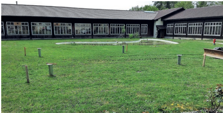
4 Stück eingebaute Flanschfundamente als Direktauflager
