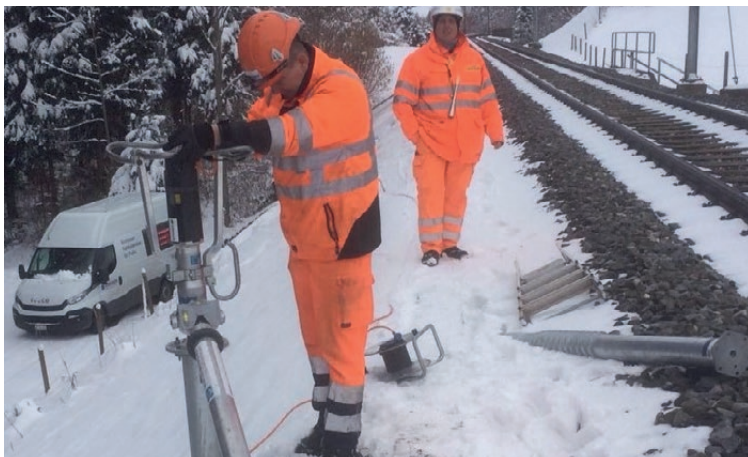
Einbau direkt an Bahnstrecke mit tragbarer elektrischer Eindrehmaschine
