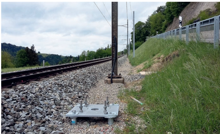
Fertig erstelltes Mastfundament mit Adapterplatte auf 4 Schraubfundamenten
