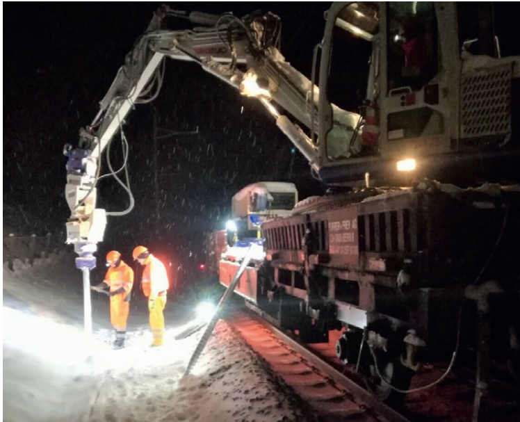
Einbau ab Bahnwagen mit Bagger und Baggeranbaugerät
