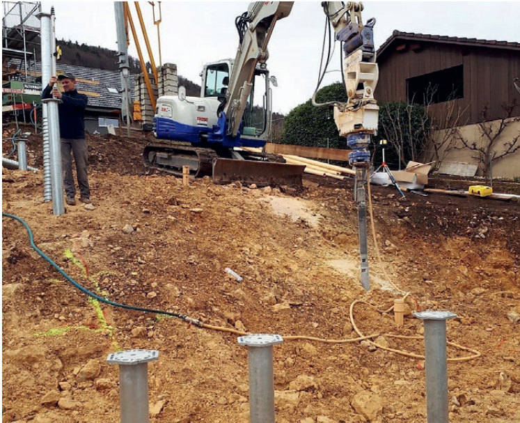
Vorbohren der Fundamentpositionen mit Baggeranbaugerät im Juragestein
