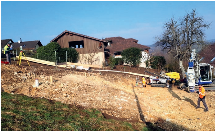
Fundamenterstellung in Hanglage
