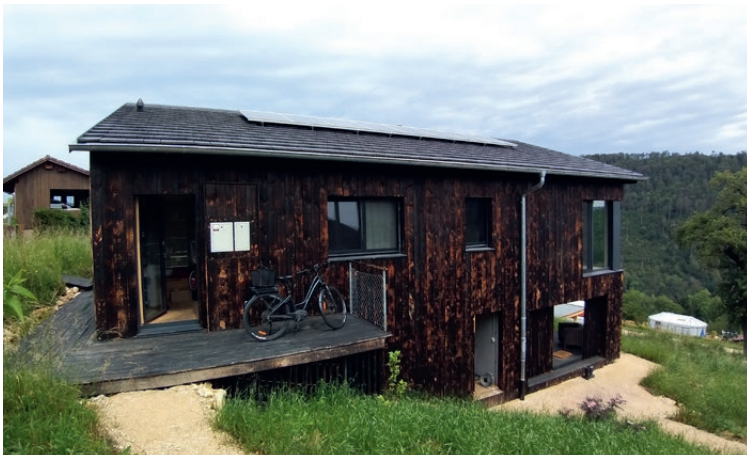
Das Haus und die Terrasse stehen auf Schraubfundamenten.
