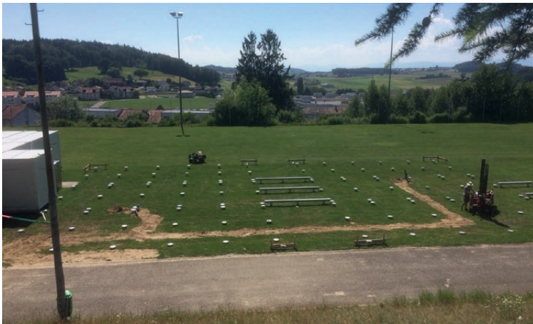
Fundamentbau ohne Abhumusierung, ohne Bodenversiegelung
