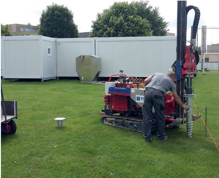
Einbau der Schraubfundamente mit KR D 55
