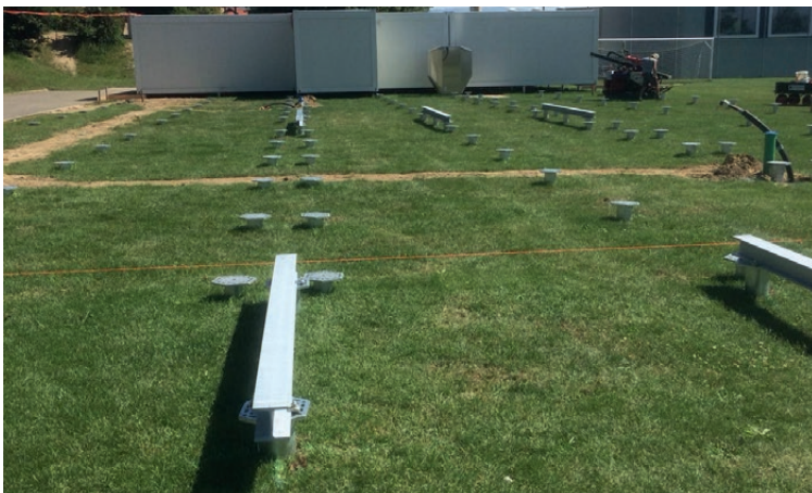
Der Ausbau erfolgte in mehrere Etappen
