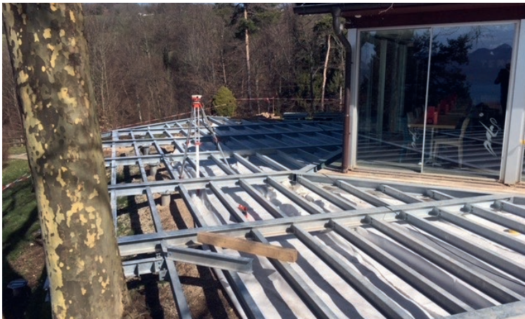
Montage der Metallkonstruktion
