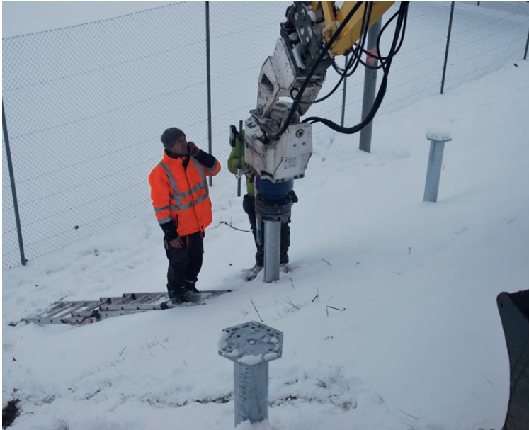
Einbau eines 3.5m langen Schraubfundamentes mit Baggeranbaugerät
