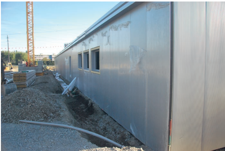
Fertigstellung des Gebäudes und der Leitungen
