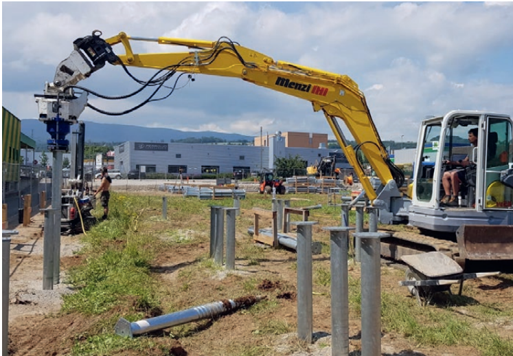
Einbau Schraubfundamente mit Baggeranbaugerät KR B 250, nach Imlochbohren
