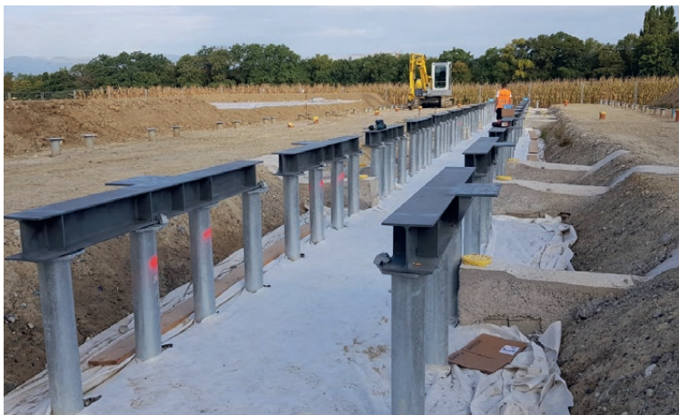
Montierte Stahlprofile als Auflage
