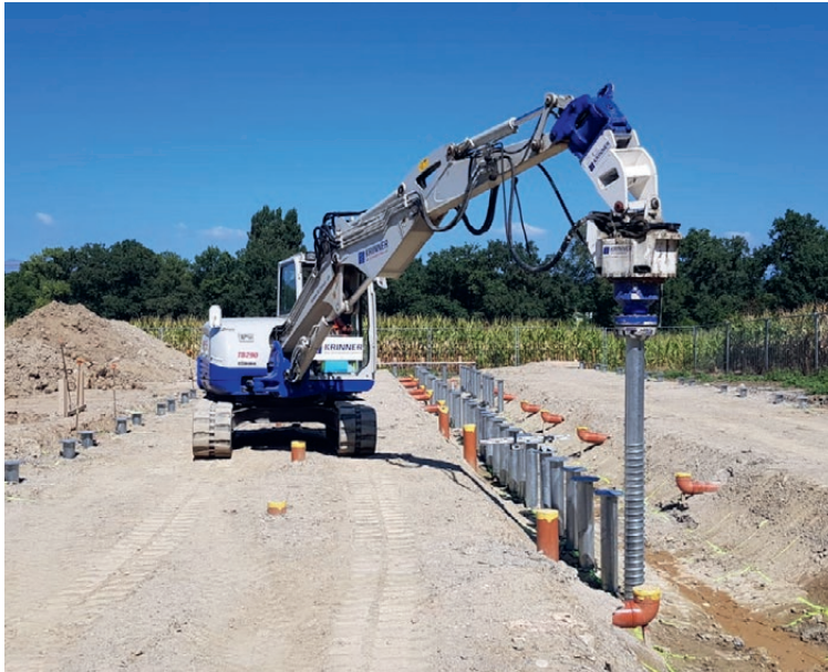
Einbau der Schraubfundamente mit Baggeranbaugerät KR B 250
