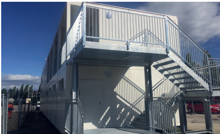
Gesamtansicht des Bürogebäudes mit Treppenanbau.
