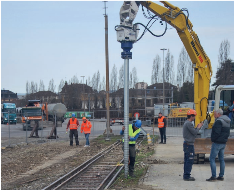
Einbau mit Baggeranbaugerät KR B 250 zwischen den Geleisen
