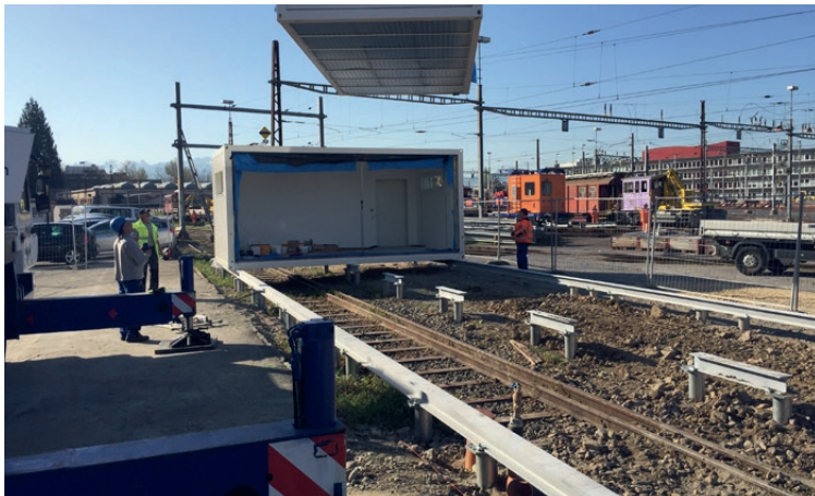
Absetzen der Raummodule auf der Gebäudeplattform
