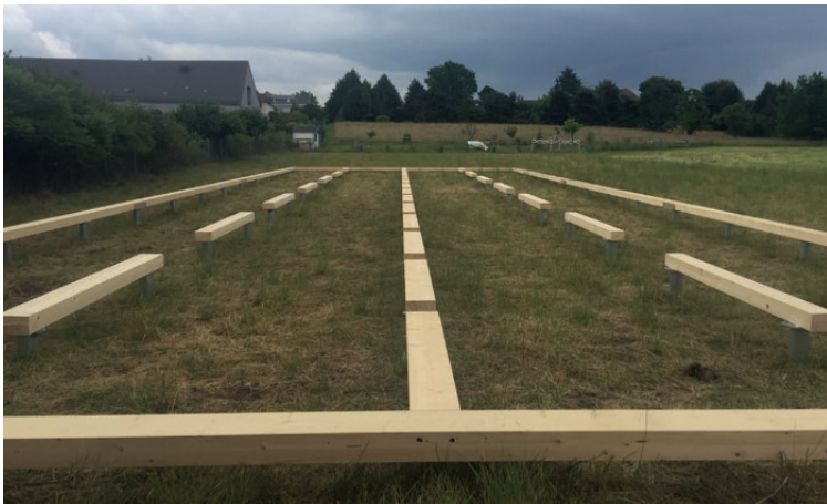
Erstellung der Gebäudeplattform mit Holzbalken
