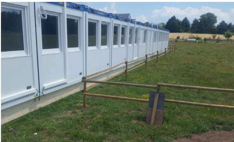
Eingeschossiges Schulprovisorium aus 28 Containern
