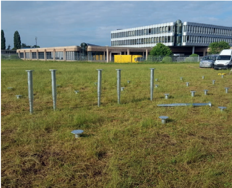
Bodenschonender Fundamentbau auf der grünen Wiesen.
