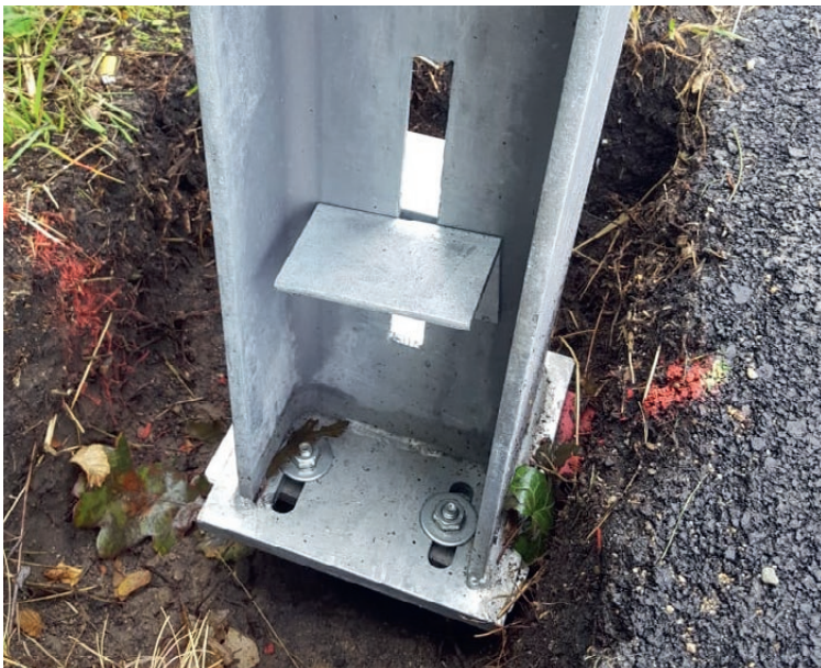
Detail der Stahlstütze mit höhenverstellbarer Auflage
