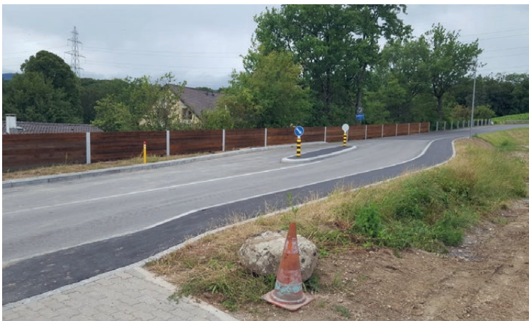
Lärmschutzwand während Fertigstellung
