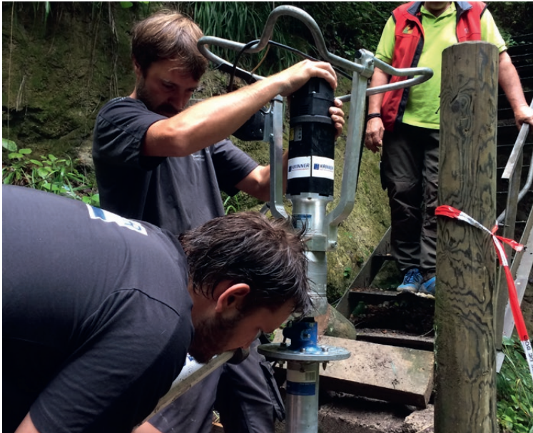
Elektrischer Einbau der Schraubfundamente beim Treppenabstieg
