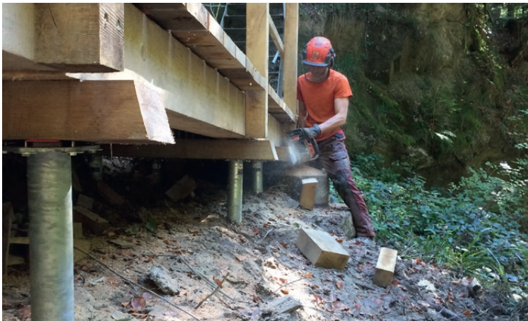
Die Holzunterkonstruktion ist mit den Schraubfundamenten verschraubt.
