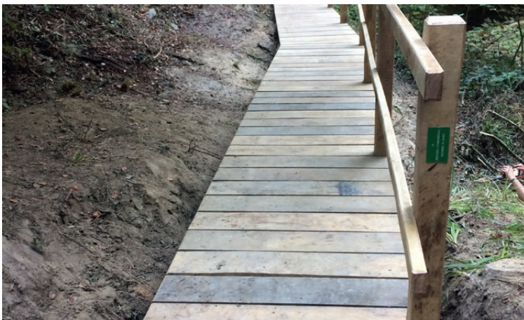
Fertig erstellt Holz-Passarelle mit Handlauf
