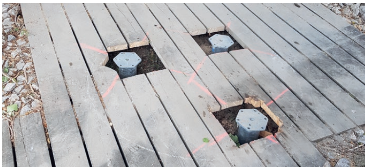
Eingebaute Schraubfundamente im Wurzelbereich
