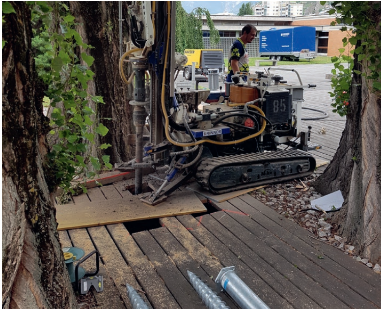
Vorbohren in felsigem Untergrund zwischen Terrassenausschnitten
