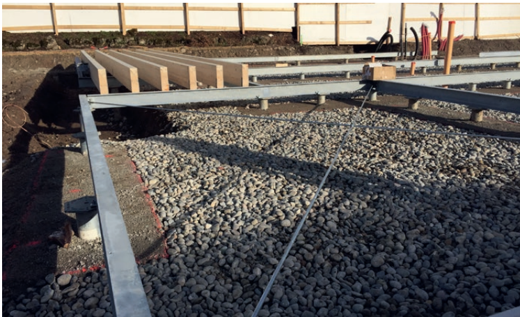
Erstellung einer versteiften Plattform für den Erweiterungsbau
