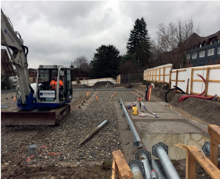
Schraubfundamente und Stahlträger für das Provisorium
