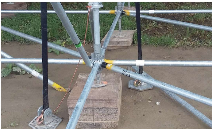
Detail der Zugabspannung des Tribürendaches
