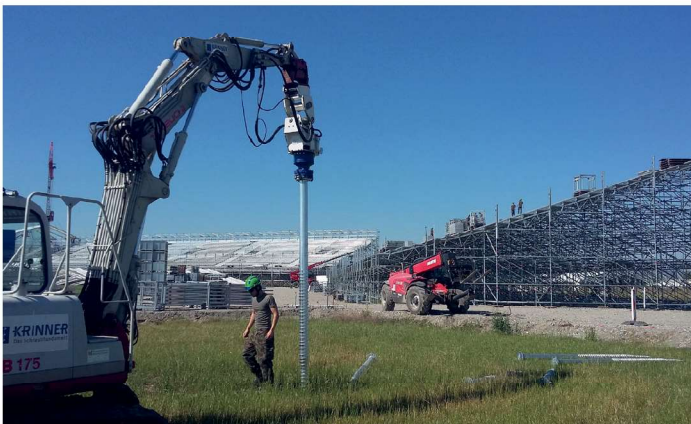
Einbau der Schraubfundamente mit Baggeranbauerät KR B 250
