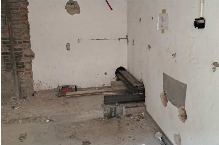
Auch bei engen Platzverhältnissen können KSF metertief gesetzt werden
