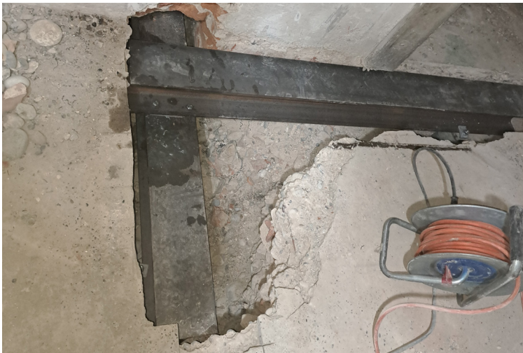
Fertige Kellerabstützung innerhalb von 9 Stunden fundiert
