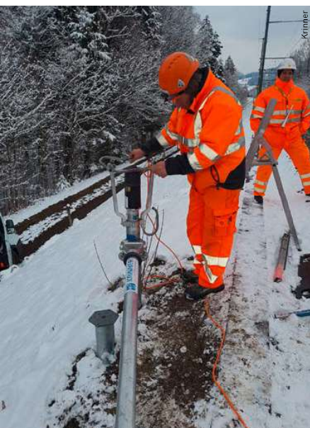
Einbau Schraubfundament mit tragbarer Elektromaschine während einer Tageschicht
