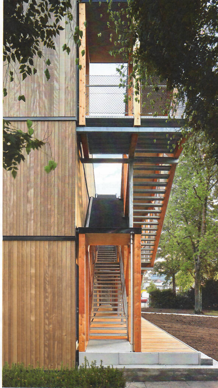
Die Primarschule La Champagne in Biel ist von der Renggli AG in Modulbauweise errichtet worden.
