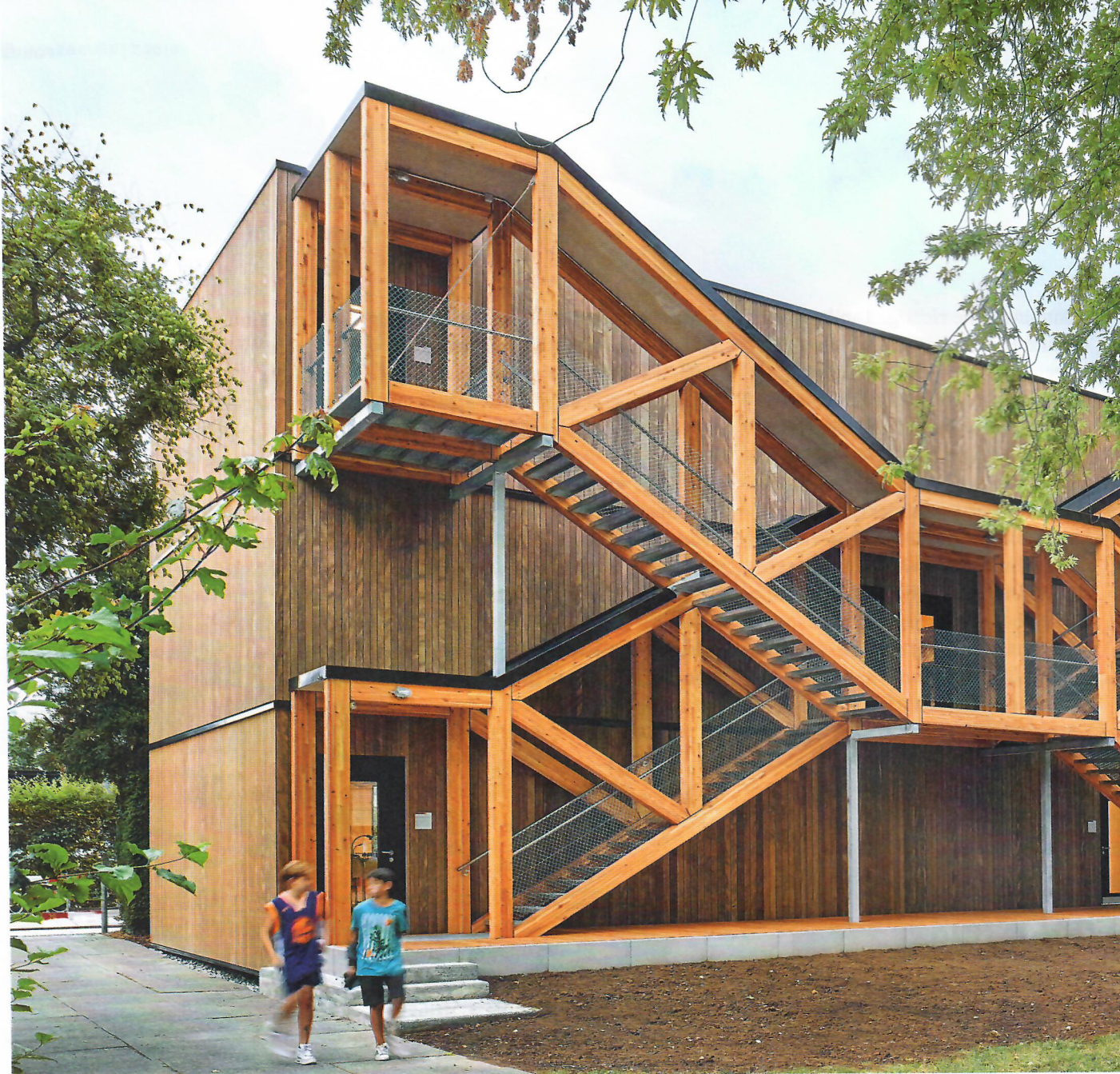
Die aussen vorgesetzte Treppenanlage ermöglichte nicht nur eine kostengünstige Bauweise mit vorgefertigten Raummodulen, sondern ist auch das prägnante Gestaltungselement.
