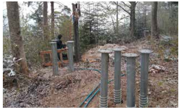
Krinnerschraubfundamente vor dem Eindrehen.
