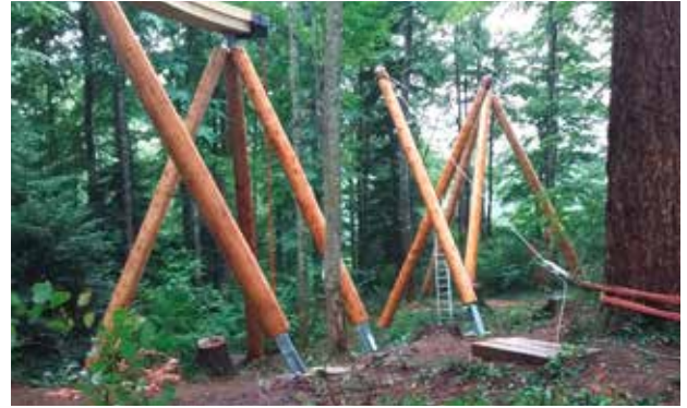
Baumwipfelpfad Mogelsberg (im Bau befindlich).
