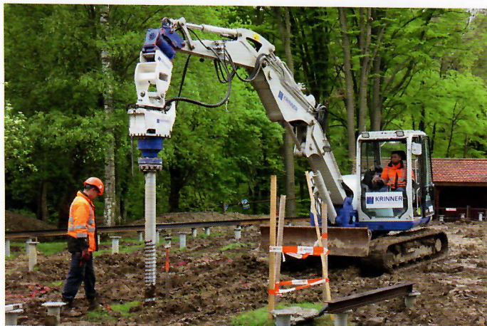
Das Baggeranbaugerät ermittelt das Drehmoment und liefert die Daten zur Auswertung für die Fachspezialisten und den Bauingenieur.
