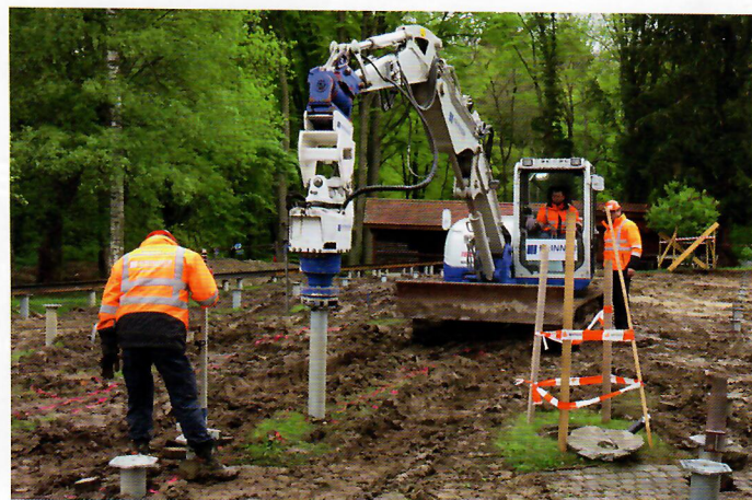
Im Resultat entsteht eine millimetergenaue Plattform. Per Rotationslaser wird die genaue Eindrehtiefe ermittelt.
