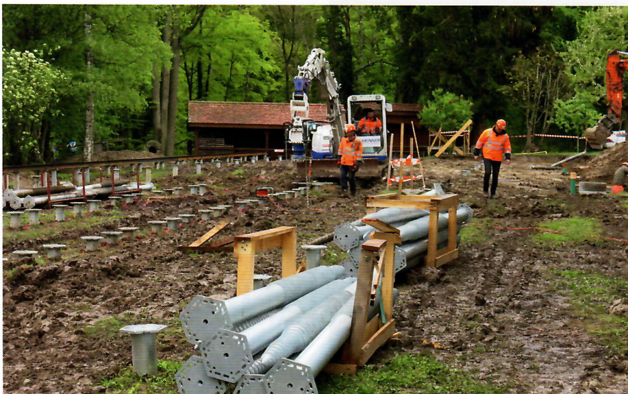
Erstellen einer präzisen Gebäudeplattform auch bei Dauerregen. Für das Schulhausprovisorium in Fribourg werden 300 Schraubfundamente und 240 Meter verbaut.
