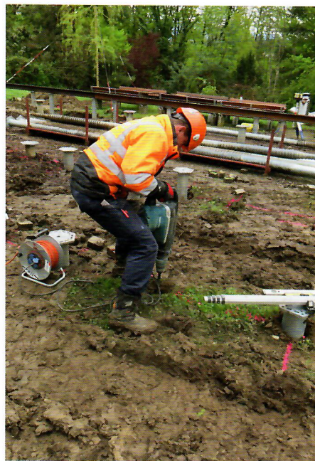
Elektrisches Vorbohren ermöglicht den Einbau auch bei Kies. Im Fels erfolgt der Einbau nach dem Vorbohren mittels Imlochbohrverfahren.
