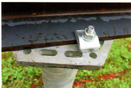
Die Stahlträger werden mittels Klemmung fixiert und bilden so ein Linienauflager für die Container.
