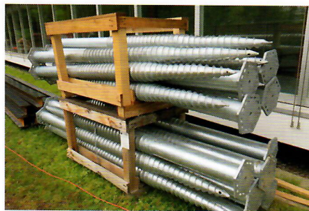
Schraubfundamente auf der Baustelle. Durch den Wegfall von Aushub und Beton reduziert sich der Transportaufwand. Die Materiallogistik ist einfach.
