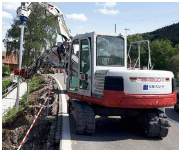
Einbau Schraubfundamente.
