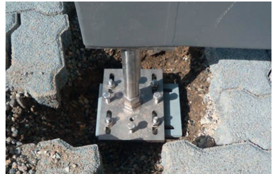
Vielfältige Befestigungsmöglichkeiten – Pfostenträger für SBB-Zweiradunterstände
