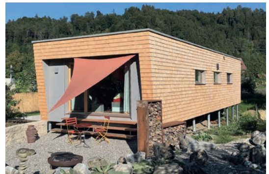
Wohnhäuser – als Tagesbaustelle fundiert
