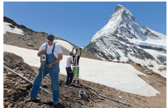
Kompakte Spezialgeräte erlauben den Einbau auch im Fels
