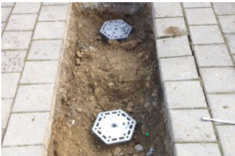
Zwei eingebaute Schraubfundamente
