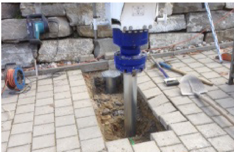
Einbau der Schraubfundamente mit Baggeranbaugerät KR B 250
